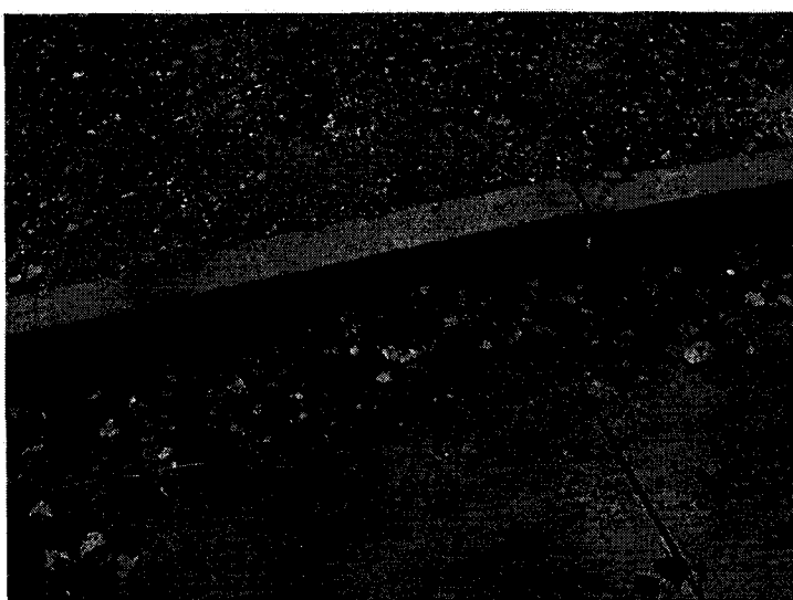
Fotografía N° 16: No se visualiza el sello impermeabilizante entre la solera y el pavimento de hormigón.
