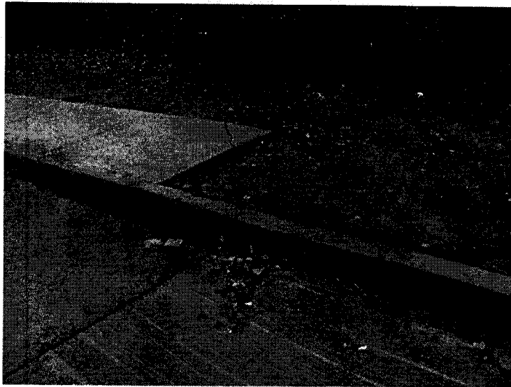
Fotografía N° 20: Se visualizan nidos de piedras en relleno de cámara de sumidero.
