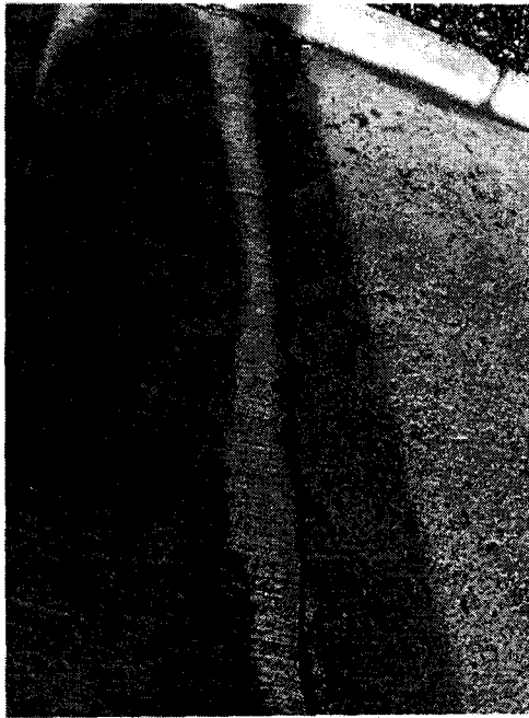
Fotografía N° 10: Fisura en km. 0,345 de calle Amancal.
